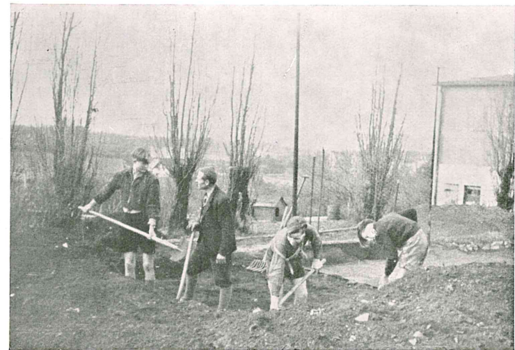
Die Jugend beim Wiederaufbau der Platzanlage - 1949
